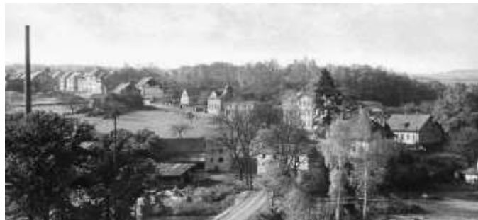
Blick ins alte Alaunwerk aus nordöstlicher Richtung
