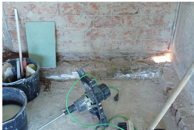
Es gab so einige Überraschungen während des Umbaus. Hier eröffnete sich ein unerwarteter Blick nach draußen. (© Monique Scholz)
