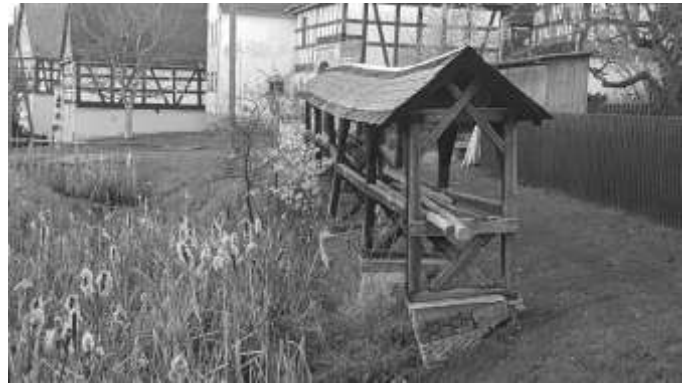
Leiterhaus vor der Sanierung
