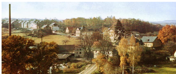
Blick ins alte Alaunwerk aus nordöstlicher Richtung
