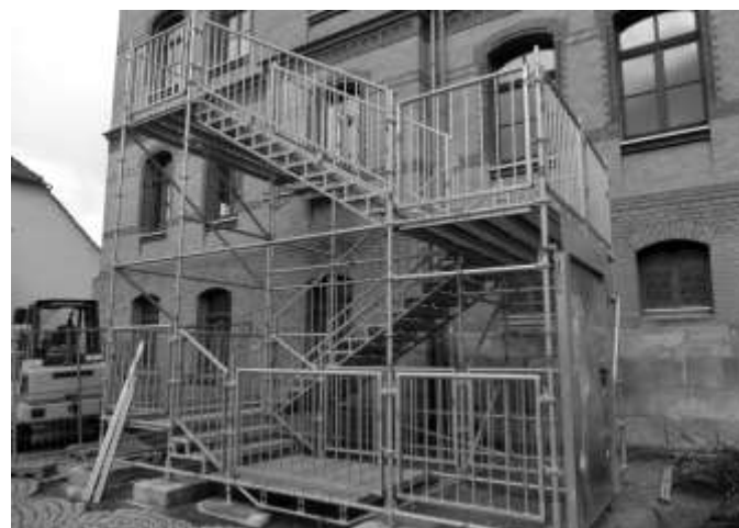
Foto: Tobias Cyliax Über die weiteren Bauarbeiten werde ich in der nächsten Ausgabe informieren.
